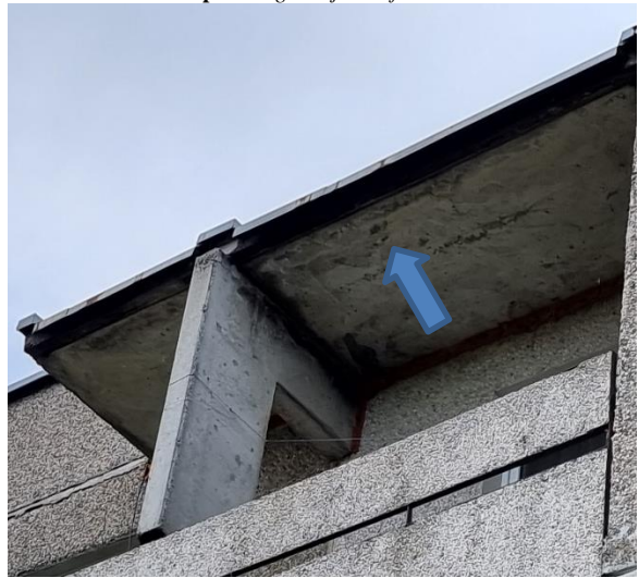
10 pav. Balkonų stoginių būklės fragmentas.
