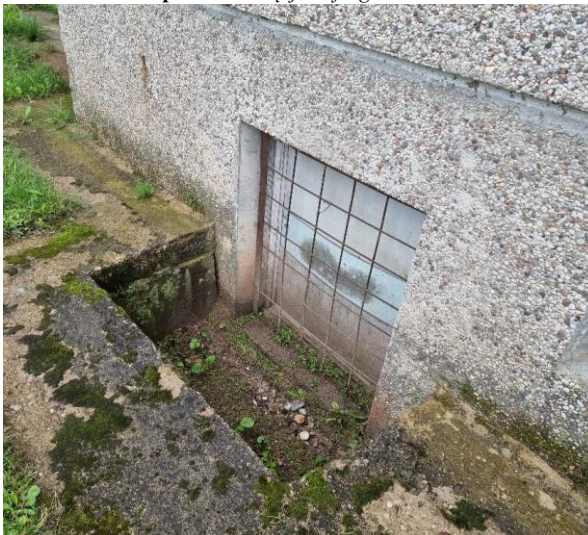
9 pav. Cokolio pažeidimų ir šviesduobių fragmentas.
