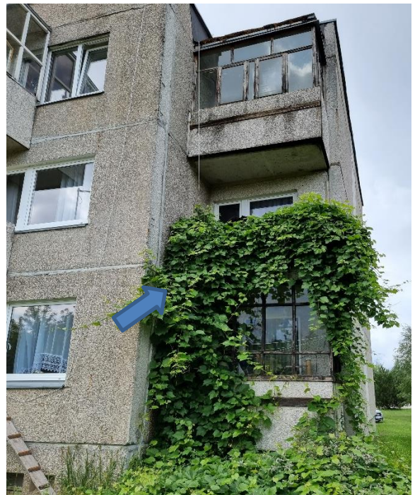
8 pav. Augmenija ant fasado.
